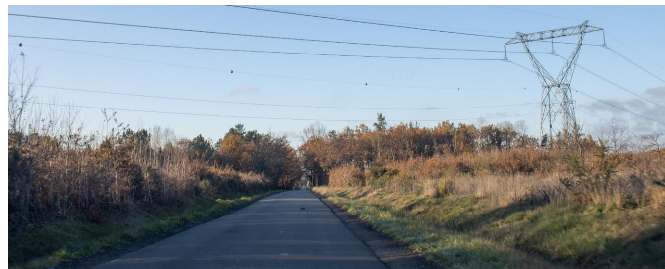
Photo 27. De nombreuses lignes électriques
