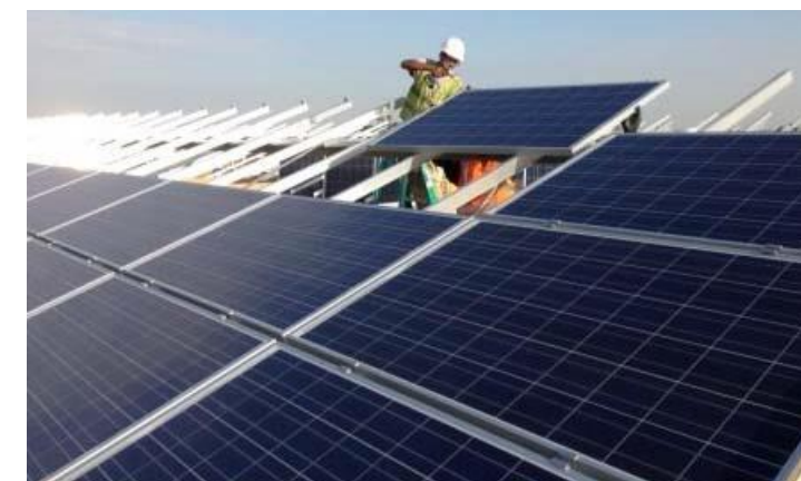
Photo 33. Exemple de mise en place des panneaux sur les structures
