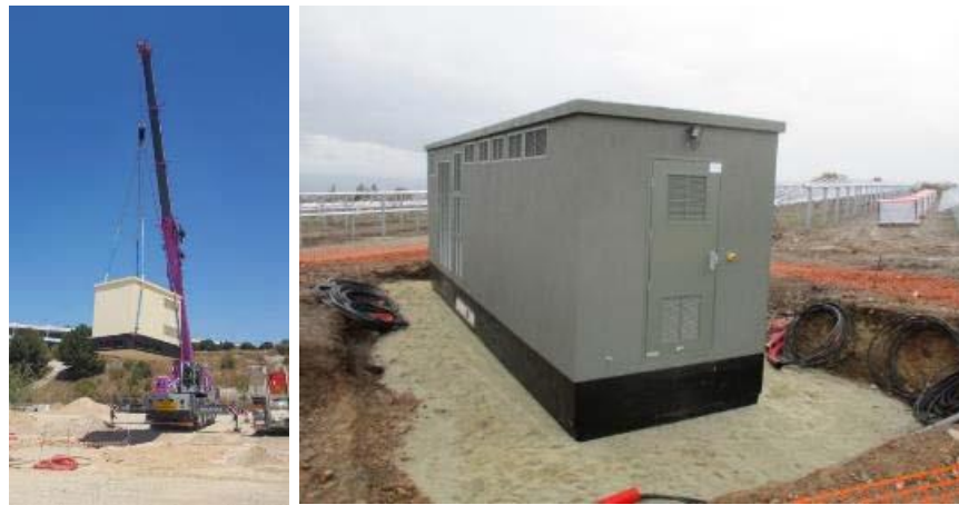
Photo 35. Installation d'un poste électrique
