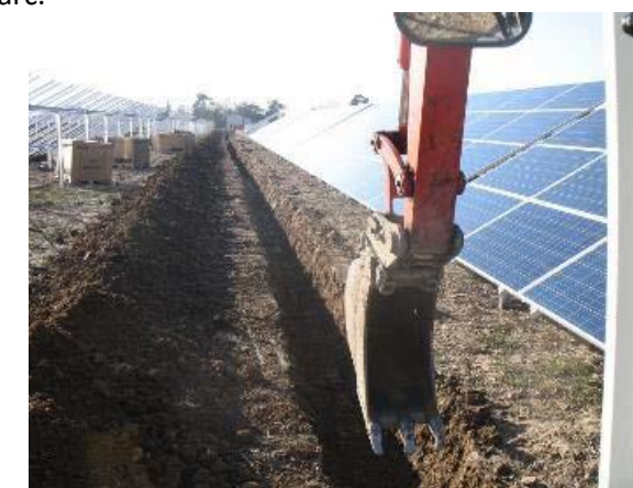
Photo 34. Exemple de tranchée entre deux tables photovoltaïques
